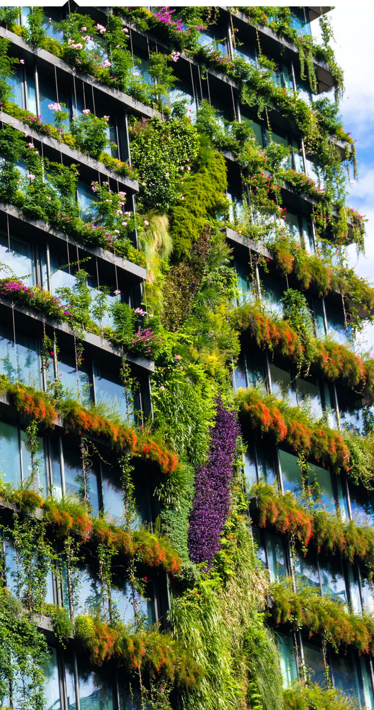
Edificio de rascacielos verdes en Sydney (Australia)
