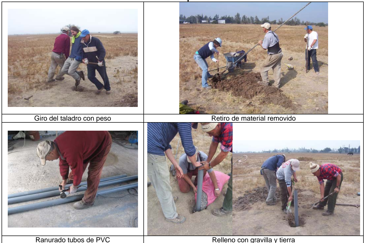
Figura 6.10 Instalación de piezómetros
