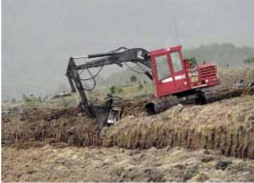
**Etapa 3.** Remoción mecánica de la cubierta vegetal e inicio de la extracción de turba a través de la construcción de sistemas de canales.
