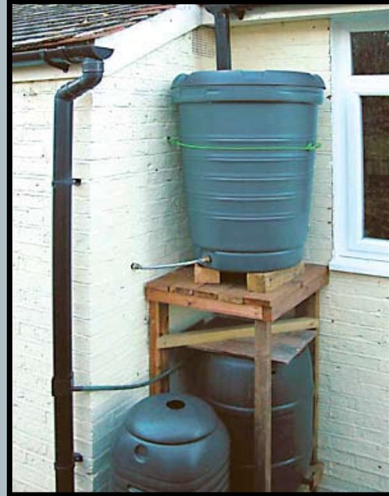
Este estanque de recolección de precipitaciones está conectado directamente a la tubería del inodoro doméstico. Debido a que está ubicado por sobre el estanque del inodoro, no es necesario bombear.
