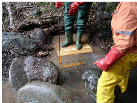
Figura 87: Instalación de barras de refuerzo.
