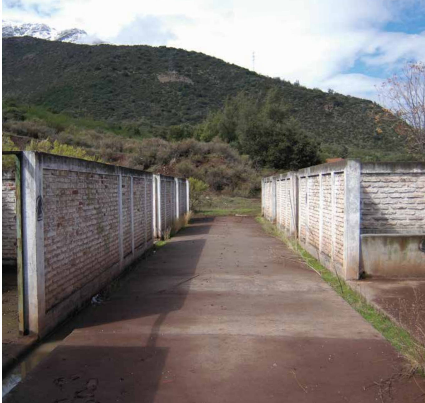
Caballerizas: estructura de hormigón y ladrillo (albañilería confinada) de 480m 2 , que antiguamente albergaba los caballos del Ejército y que hoy está convertida en el centro de visitantes del Centro de Educación Ambiental.
