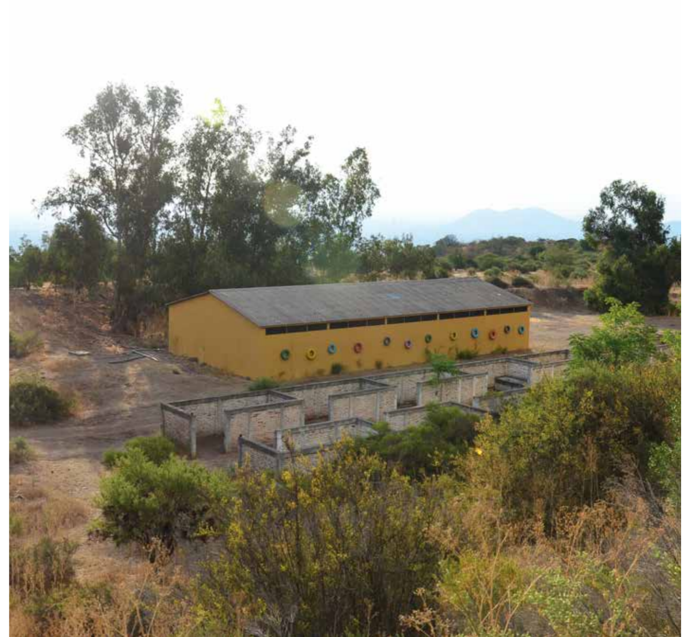
Galpón: frente a las caballerizas existía una estructura cerrada y techada de 340m 2 aprox., construida con marcos y vigas de acero, que se usaba como bodega general. Hoy es un gran área de encuentro y actividades grupales.
