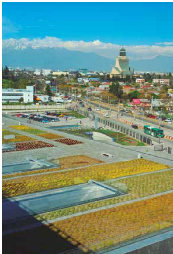
Hospital El Carmen (Maipú), Cubierta vegetal | TECPRO.
