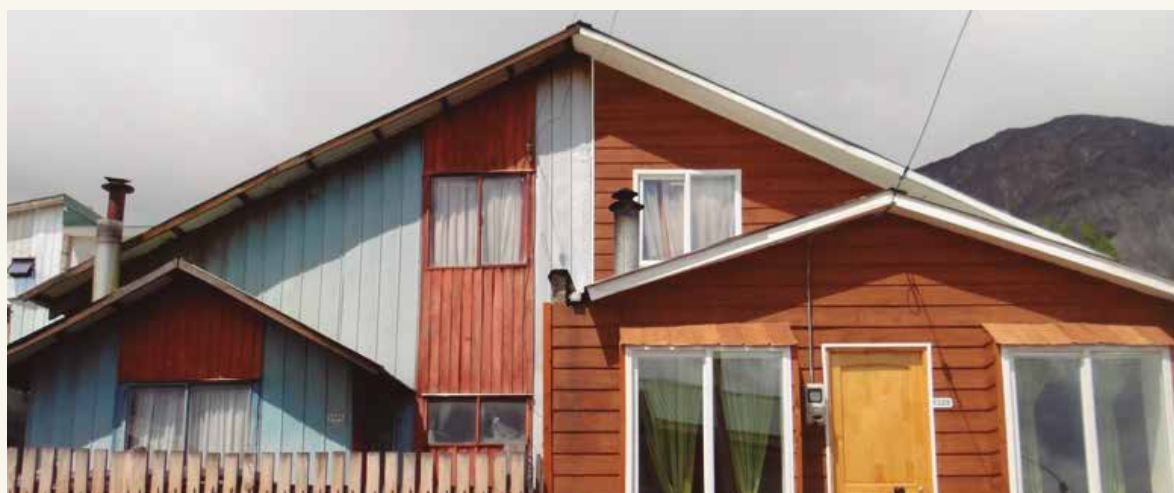
Viviendas con (der.) y sin (izq.) aislamiento térmico, Coyhaique | JIMENA SILVA
