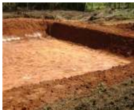
3 meses de obras
