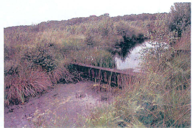
(d) Sheet metal dam across wide fire-break; Risley Moss (Cheshire).
