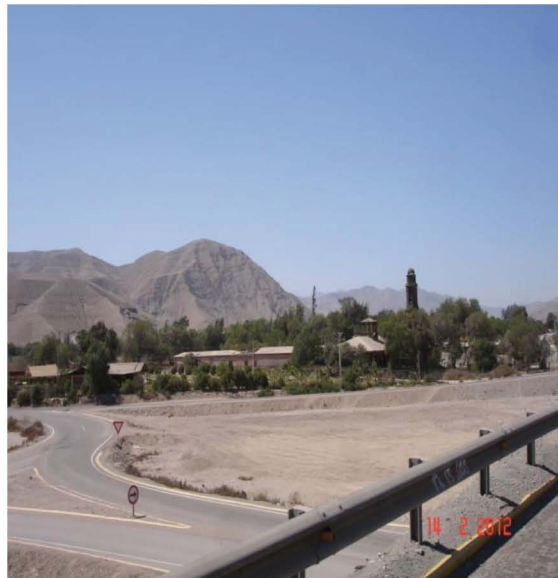
Fotografía N°4: Vista localidad de Nantoco desde paso sobre nivel (3-A)
