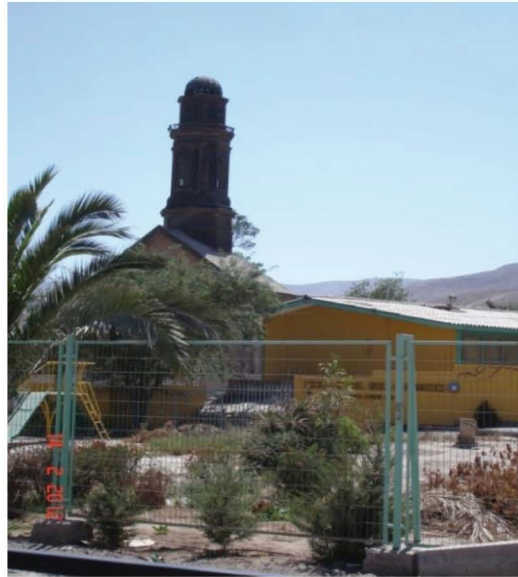
Fotografía N°3: Torreón Iglesia y escuela de Nantoco (3-A)
