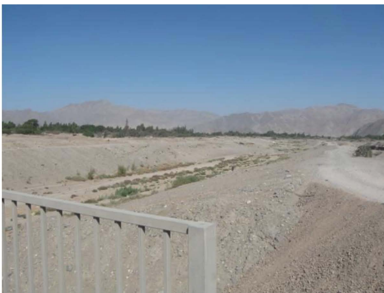
Fotografía N°18: Vista hacia el sur Río Copiapó desde Puente Viñita Azul (4-B)
