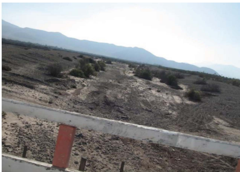
Fotografía Nº20: Extracción de áridos en sector Punta Negra (Puente Viñita Azul) (5-B)
