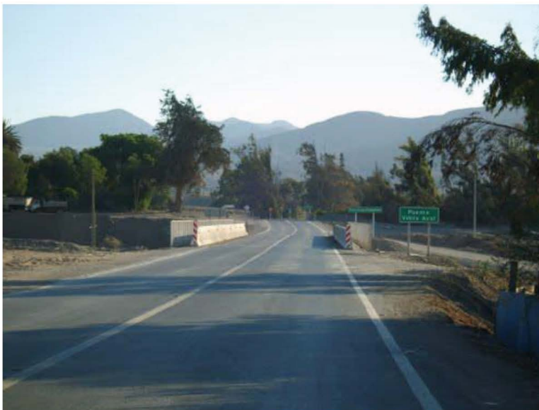
Fotografía N°15: Puente Viñita Azul (4-B)
