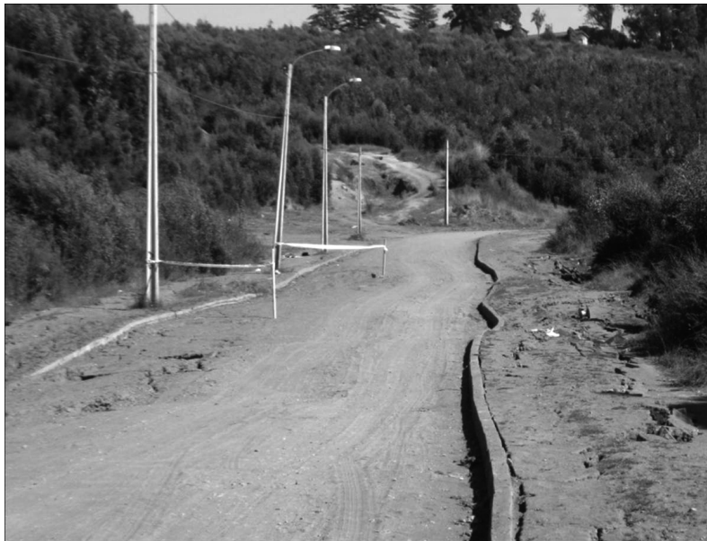
Figura N° 15 Ondulación del terreno debido a las ondas Love en el puente Maule de la ciudad de Coronel (37°S).
