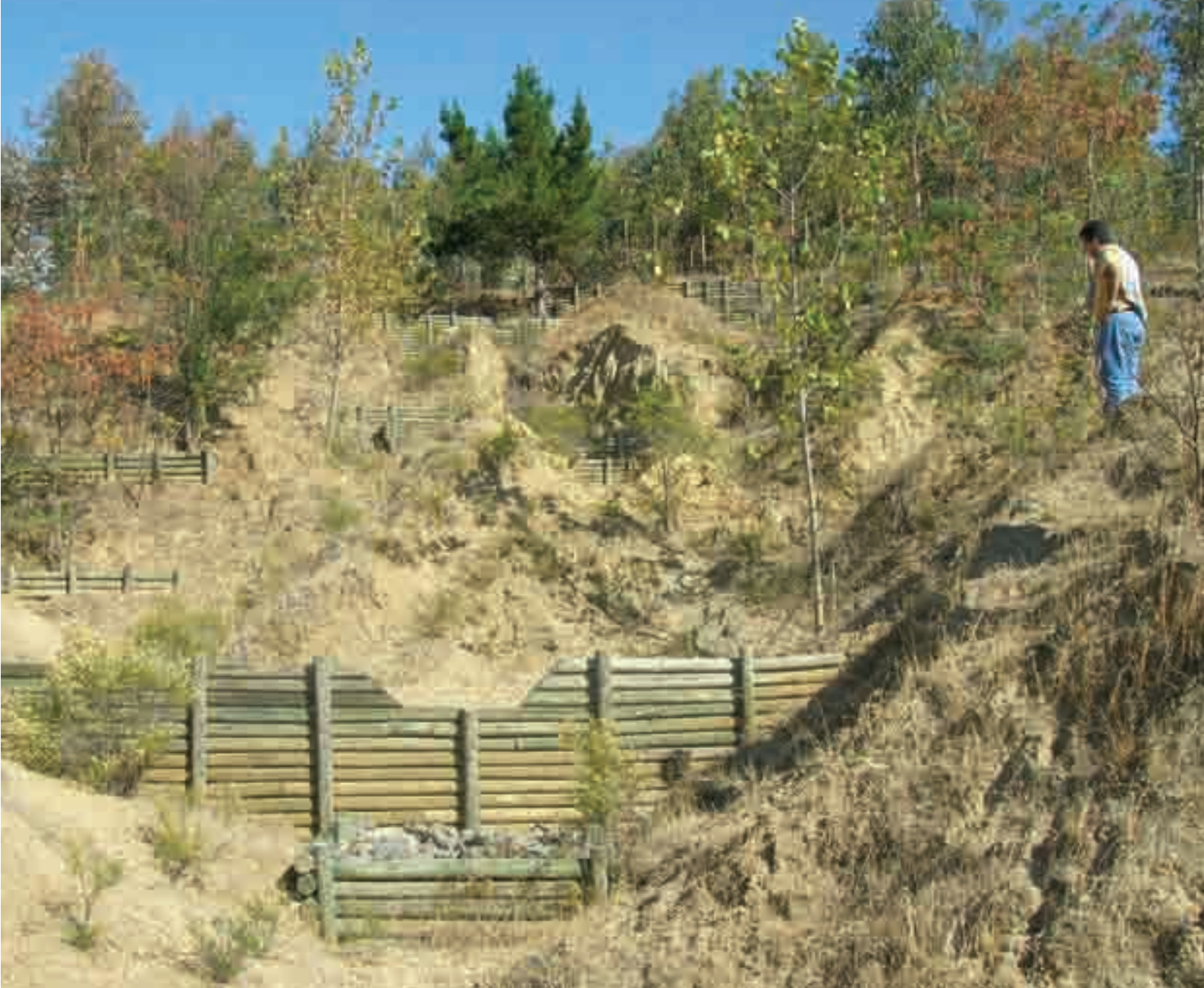
Tratamiento de cárcavas para recuperación de suelos, Angol, Región de La Araucanía.
