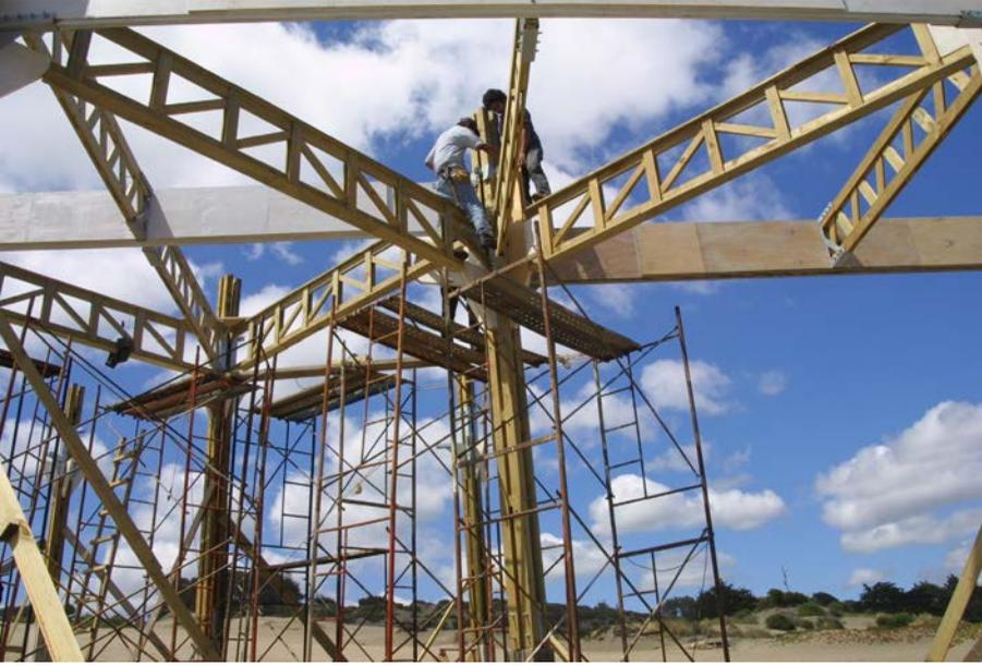
Trabajando en la unión de los elementos que conforman el primer campo espacial, que se desprende del juego realizado, lo que al interior de la faena se llamaría, la “malla”, y que se conformaría entre los pilares de 6 metros, las vigas maestras y las secundarias, las primeras destinadas a soportar las cargas de uso y las segundas en mantención de la forma.
