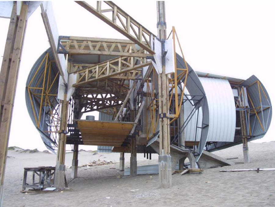
*Se consigue el cierre en la obra, en el área destinada al residencia, se pasa aun segundo estado del interior, pues los contactos en varios de las zonas corresponden a contactos deslizantes, dado que el suelo es independiente de los muros que conforman el perímetro, se trabaja con lo que se denomina los fuelles.*
