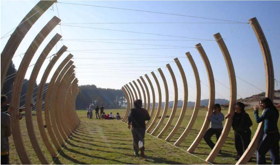
*Se trabaja con las cuadernas diseñadas en base a ensambles de madera laminada, estructura que se denomina estratificada, las distancias corresponderían a la posición en la obra, se trabaja para la ocasión en base a un sistemas de cables para que solo las curvas luzcan la condición de perfilar el interior, estos elementos remplazaran la estructura metálicas, que restan posibilidades espaciales al interior.*
