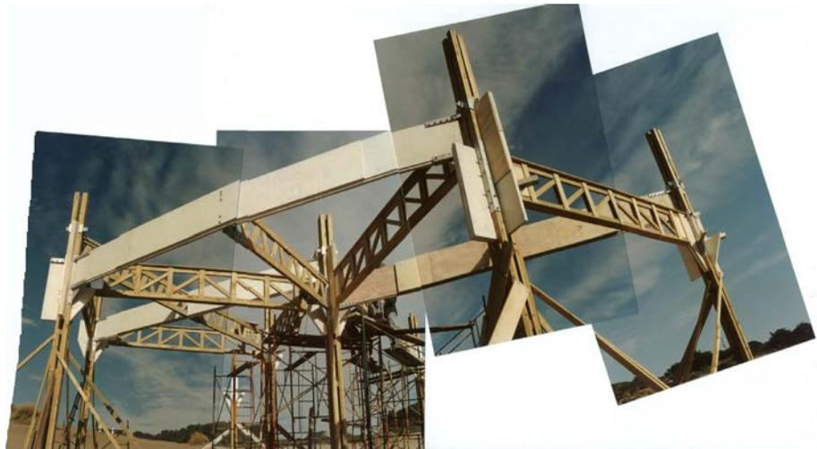
*Primera área que se levanta para implementar el sistema de rotulas. Las cuales se fijan a las vigas maestras.*
