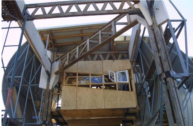
*Primer estado de habitabilidad con permanencia en el lugar, se ha tenido que diseñar una estructura independiente de acceso al modo de una rampa, la cual llega pero no se une con el suelo de entrada.*
